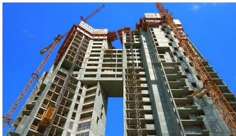
„ Sea Towers ” w budowie
